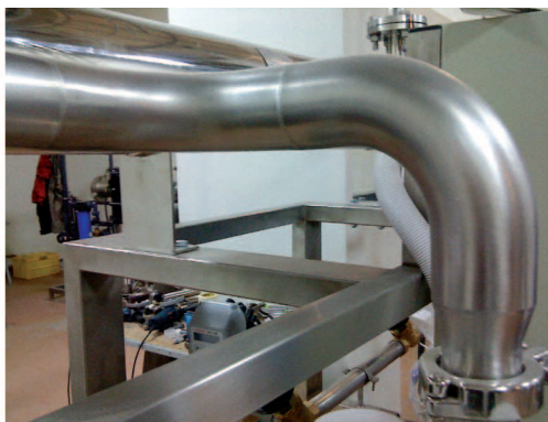
Рис. 9. Примеры монтажа систем распределения из нержавеющей стали с помощью автоматической орбитальной сварки (ООО ОРБИТАЛ)
